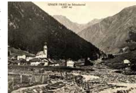
Die aus heutiger Sicht primitiven Wehrbauten bestanden aus sogenannten Böcken [in Dreiecksform zusammengefügte Holzstämmen] und „Orchen“ [Kastenartig zusammengebaute Baumstämme mit Steinfüllung] – Im Bild links unten: der ehemalige Talweg – Aufnahme aus den 30er Jahren.
